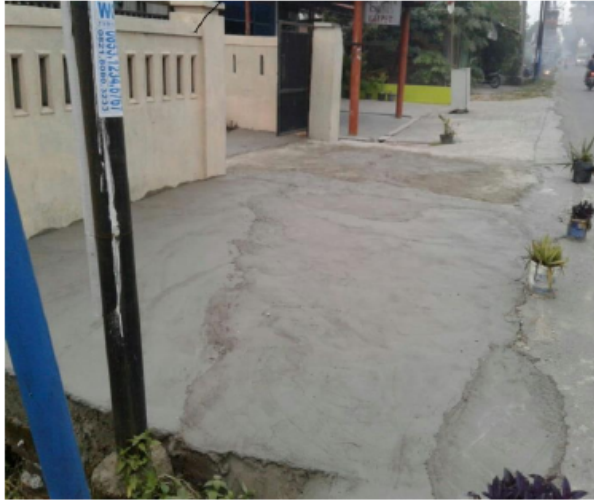
Erhöhung der Einfahrt
